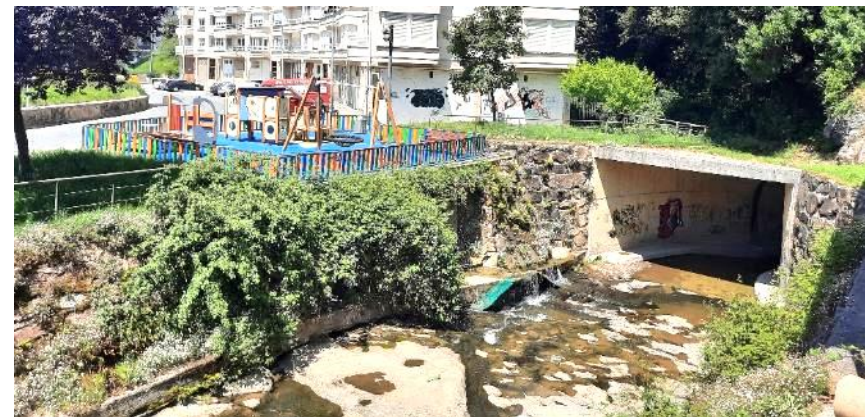
Foto 4.1 Artigas Arroa, en el punto donde se une un afluente y comienza el tramo de canalización subterránea
