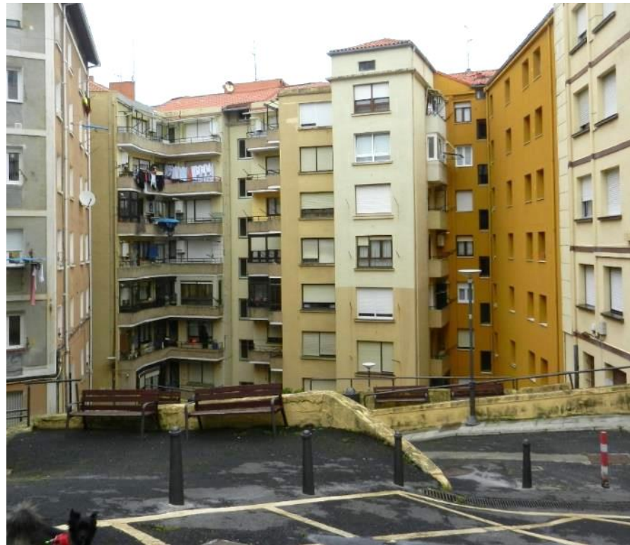
Foto 4.4 Edificios de vivienda en Bermeo
