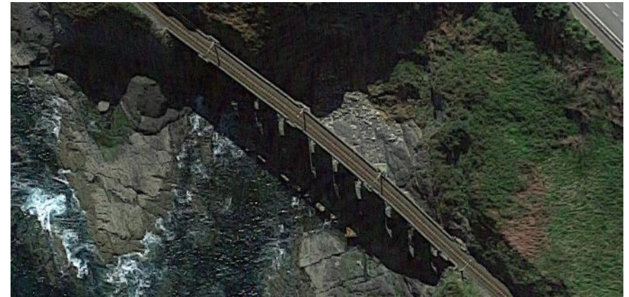
Foto 4.8 Viaducto de Lamiaran
